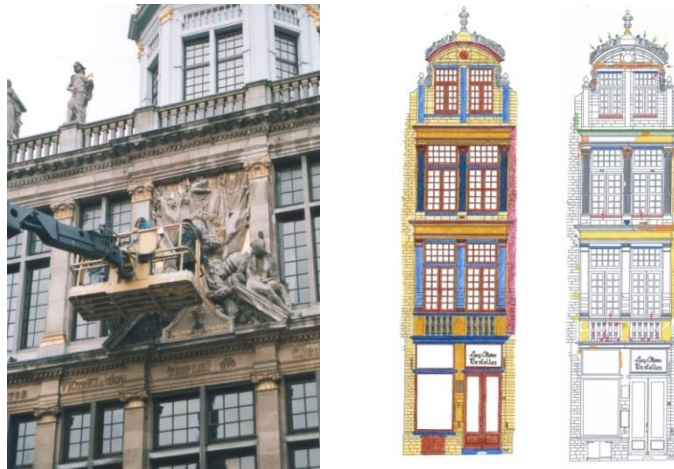
Survey of materiel and pathologies from a lifting platform © Ville de Bruxelles, Département Urbanisme, Cellule Patrimoine Historique
